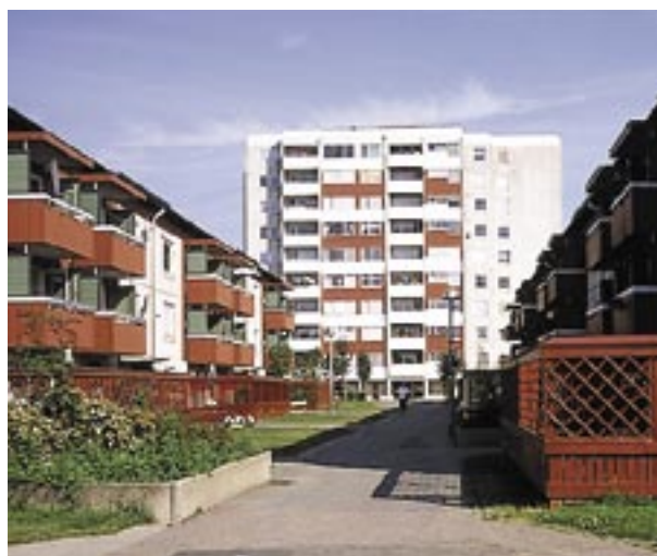
Övre Lövgårdets miljonprogramsområde i Göteborg. Energiförbrukningen för värme och varmvatten har minskat med cirka 30 procent sedan 1999, tack vare en systematisk jakt på energitjuvar.
